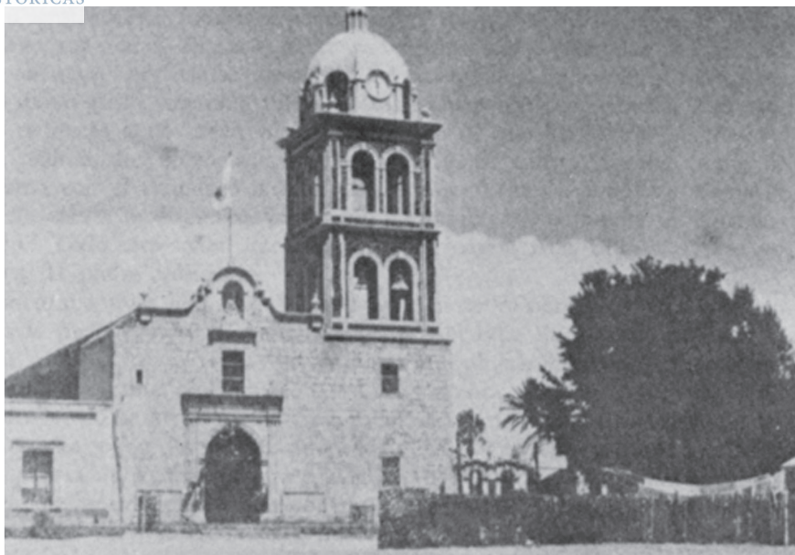
Misión de Nuestra Señora de Loreto. Fue ésta la primera fundación permanente en las Californias (1697). La iglesia actual fue terminada en 1752. Las restauraciones de que ha sido objeto han alterado lamentablemente su arquitectura original. Fotografía de Jorge Gurría Lacroix
